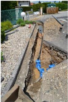
La municipalité a tenu à sécuriser l'alimentation en eau potable de la maison de retraite « Les Cèdres » en créant un deuxième branchement sur la conduite d'alimentation de Retournac. Elle peut donc dorénavant être alimentée soit par le réservoir de Gorse soit directement par le réservoir de Marnhac. Ceci permettra de pouvoir intervenir de manière plus sereine sur le réseau venant de Gorse. Merci à Mr Vérot d'avoir compris les enjeux de ce chantier et à l'entreprise Faurie pour la réalisation.
